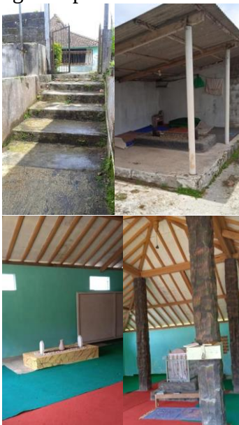
Gambar 2. Kondisi tangga, ruang berdoa luar, ruang berdoa dalam dan makam
