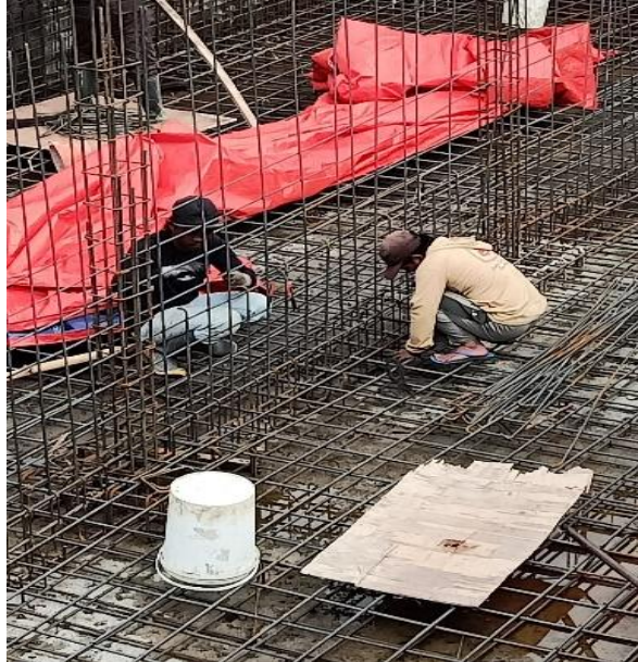
Gb.1. Proses pembesian GWT dengan minimnya penerapan k3
