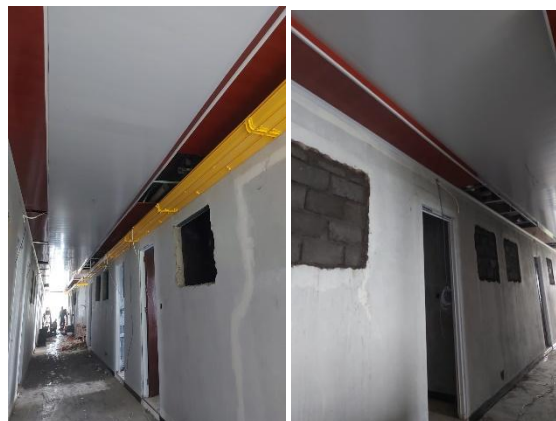
Gambar 5 Proses penutupan jendela kamar hotel
