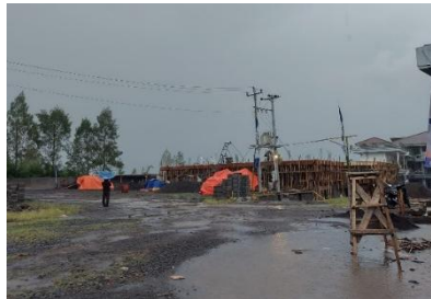
Gambar 4 Curah hujan tinggi di lokasi proyek
