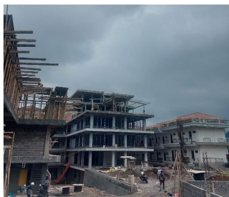
Gb 3. Proyek pembangunan Hotel Horison
