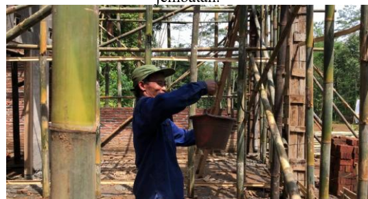
Gambar l. Aktivitas pekerjaan struktur bangunan sebagai bagian dari pengendalian mutu konstruksi.
