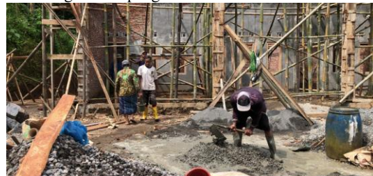
Gambar n. Pekerjaan struktur dan scaffolding sebagai ilustrasi perlunya pengawasan kualitas dan keselamatan.
