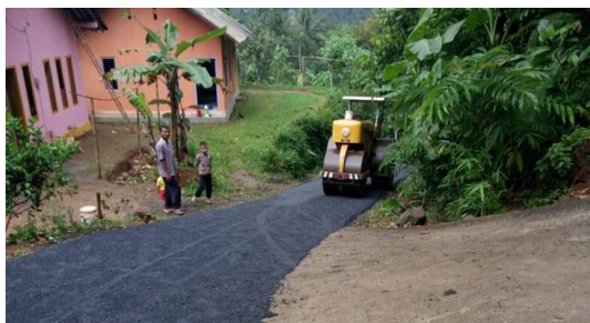
Gambar k. Pengaspalan jalur Desa Sidepok, Kepil Wonosobo sebagai contoh jasa konstruksi infrastruktur.
