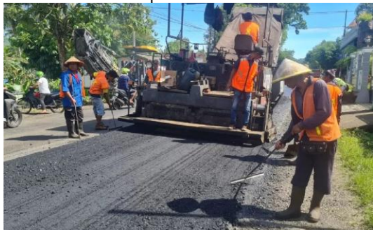
Gambar c. Proses perbaikan Jalan Purworejo KM 26 Kepil Wonosobo sebagai contoh pekerjaan infrastruktur jalan.
