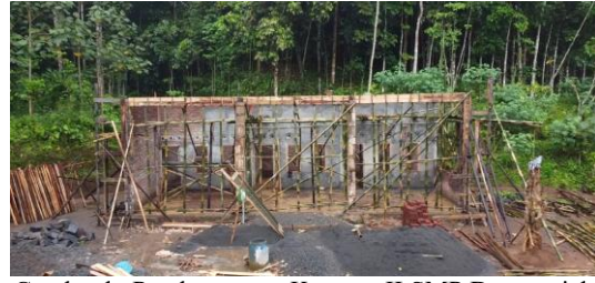
Gambar b. Pembangunan Kampus II SMP Darunnajah Al-Islamy sebagai contoh proyek bangunan komersial/institusional.
