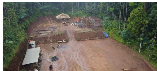
Gambar h. Lahan pembangunan Kampus II SMP Darunnajah Al-Islamy sebagai contoh pengembangan lahan konstruksi.
