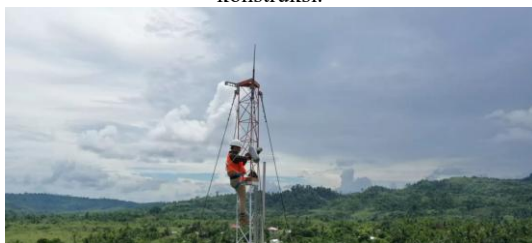
Gambar g. Proses pemasangan tower wifi di Kecamatan Kepil sebagai contoh infrastruktur telekomunikasi.
