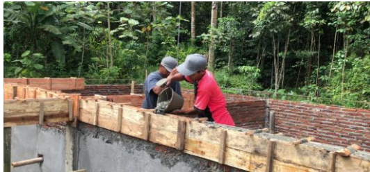
Gambar i. Aktivitas pembangunan Kampus II SMP Darunnajah Al-Islamy sebagai contoh jasa konstruksi bangunan.
