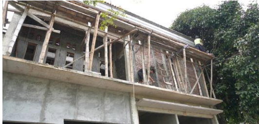
Gambar a. Pembangunan perumahan di Beran, Kepil Wonosobo sebagai contoh bentuk fisik jasa konstruksi perumahan.
